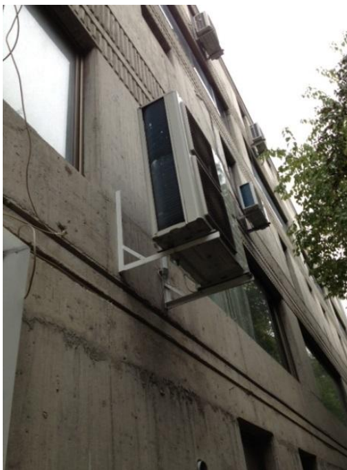
Слика 1. Местоположба и начин на поставување на надворешна единица од ТП
