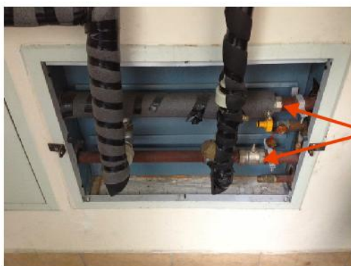
Слика 5. Поставеност на топчестите вентили на системот за греење во ормарот 2.
