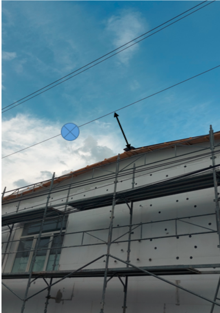
Слика 1. Приказ на местото каде настанал струјниот удар при контакт со забележаниот проводник.
